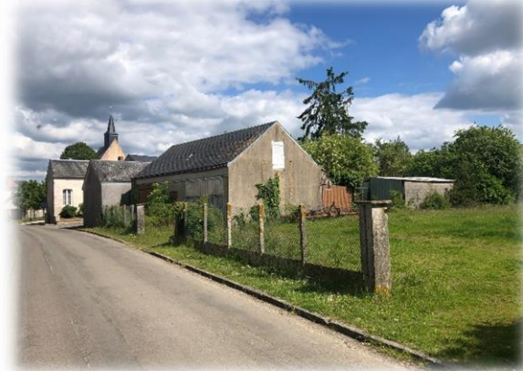
Vues depuis la rue du bourg
